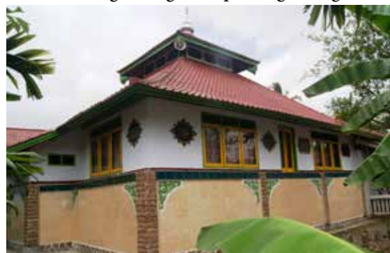
Gambar 6: Masjid Sumbek setelah direnovasi, tampak dari samping kiri, dasar bangunan yang tinggi berwarna coklat muda (ini bukan tembok keliling), dengan atap dari genteng.
